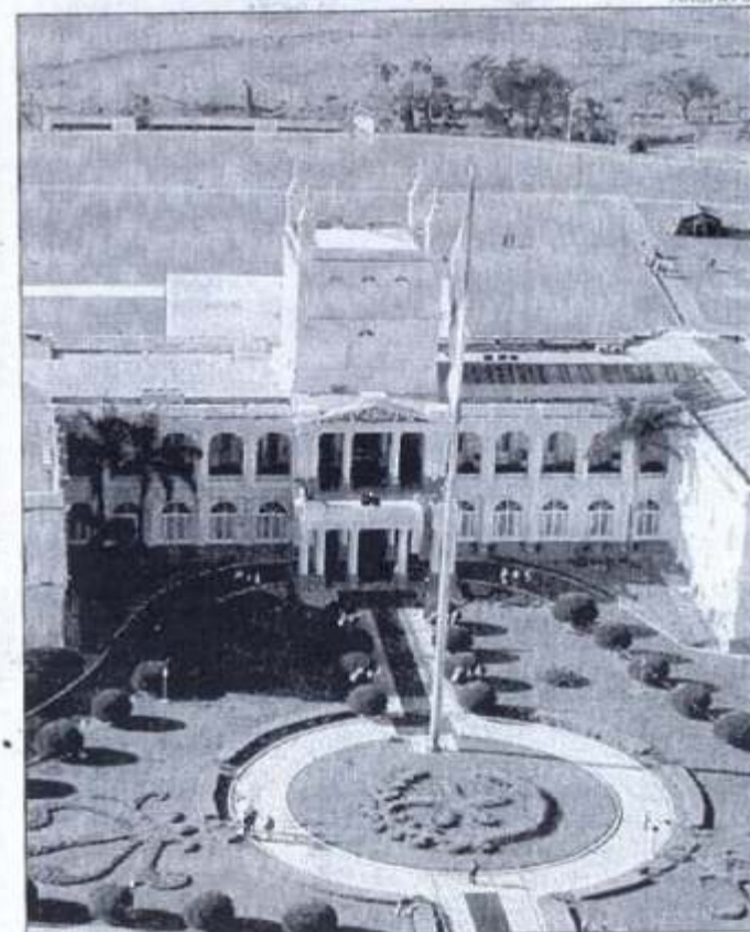
Prioridad. Para los festejos de mayo finalizarán la restauración del techo, la torre y la sala de prensa del Palacio.
